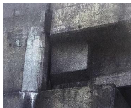
(c) 胸壁角部および主桁端部
