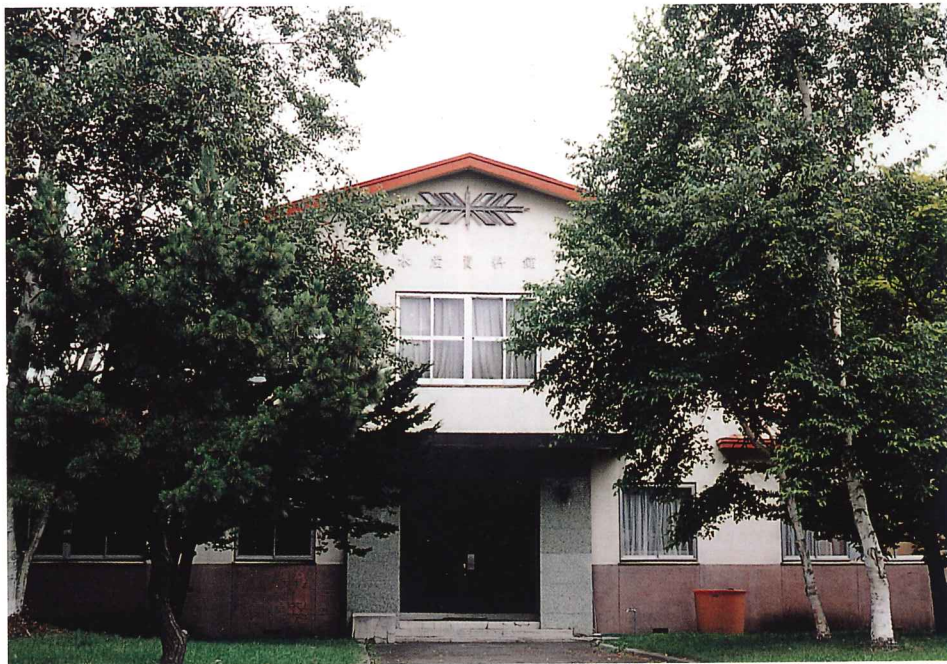
正面から見た水産資料館
