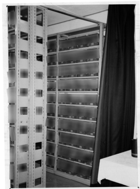
図51 第5研究室の室内現況（1984年3月）
