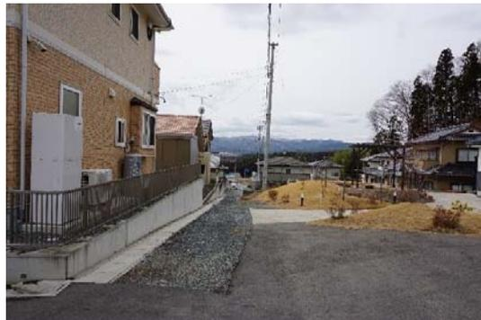
写真 3-20 自主的宅地造成による道路の未整備状況（陸前高田市）
