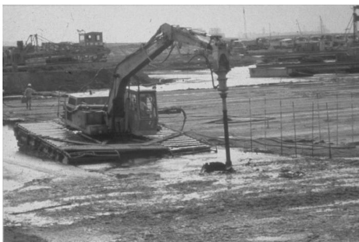
写真1. ヘドロの埋立地を空港施設に転換する工事の状況。地盤改良用の重機が走行できるように表層固化処理をしている状況からヘドロの様子が良くわかる (国土交通省関東地方整備局提供)
