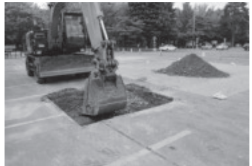
D. 調査の様子（TP 06：北東より）
