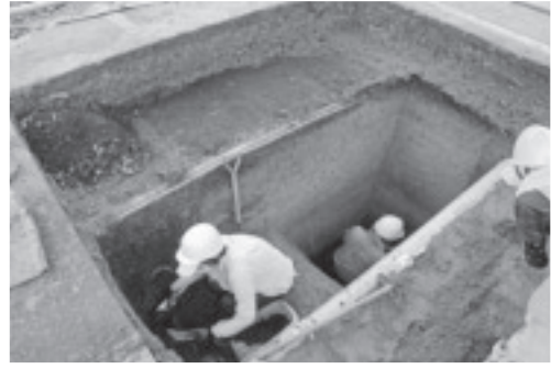
B. 調査の様子（TP 14：北西より）
