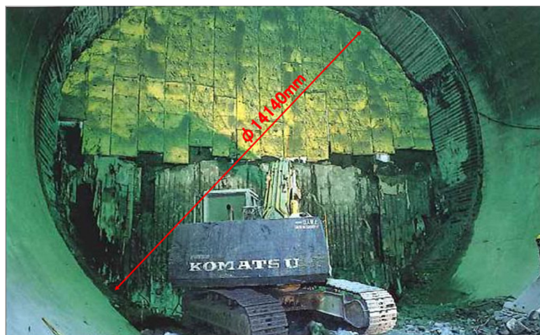
図 2-15 川崎人工島(風の塔)での発進防護凍結工事の状況
