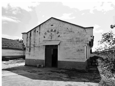
写真7右 洒普山教堂現状
