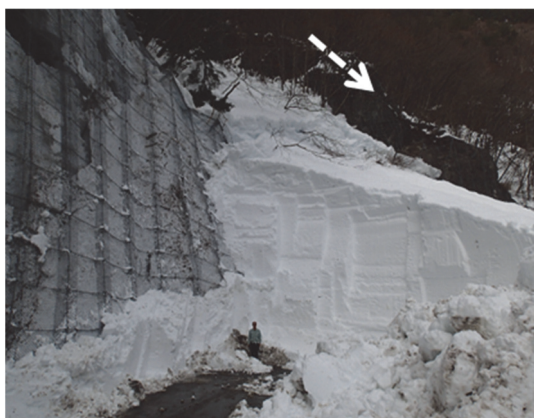
図 3-10 表層雪崩で埋没した県道 36 号（中村ら，2014）
