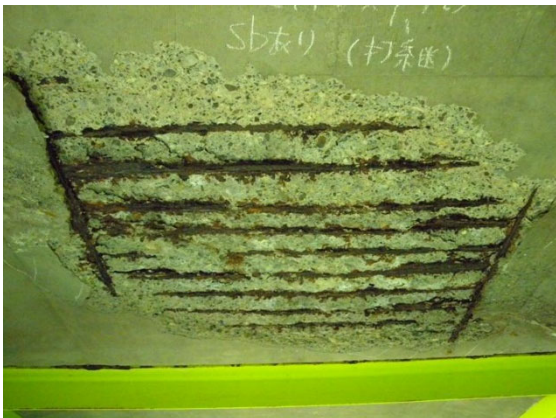
(e) 鋼橋 RC 床版
