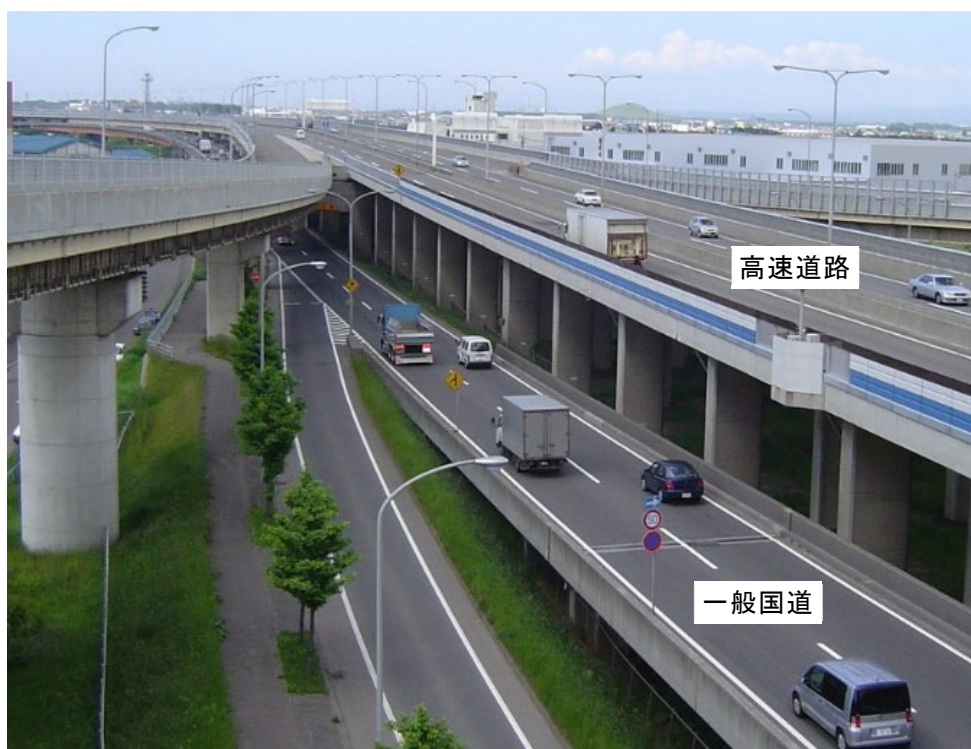
図 1.10 札幌自動車道の橋梁高架区間
