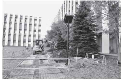
B. 北キャンパス屋外パブリックスペース道路 整備工事（北より）調査番号：2209
