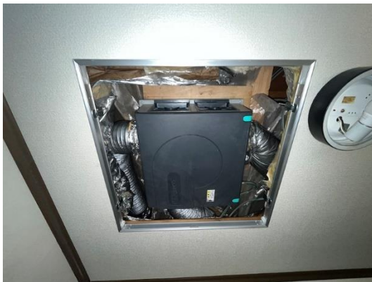
(iii) 天井復旧&ファン交換完了
