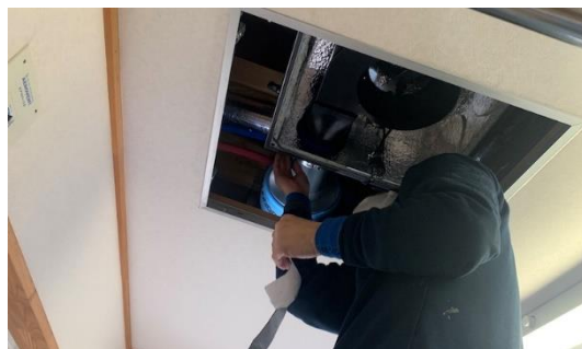
(iv) 交換換気システム本体取付け
