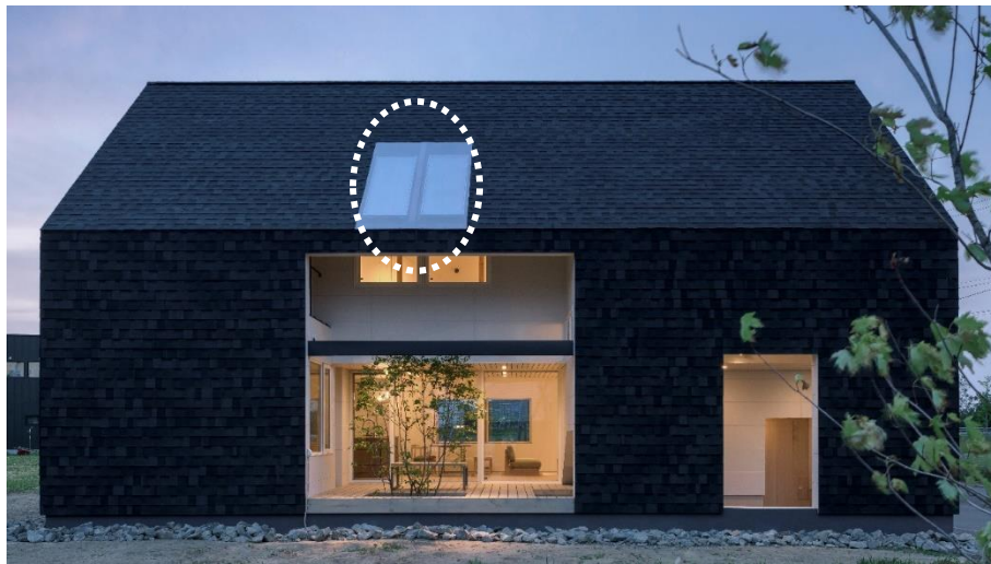
図 6.1 屋根に収めた事例（ポリカーボネートと一体化、北海道南幌町）
