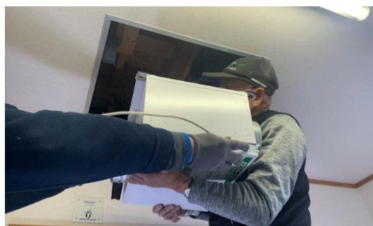
(ii) 故障換気システム本体取外し
