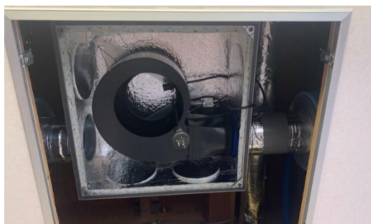
(v) 交換換気システム本体取付け完了
