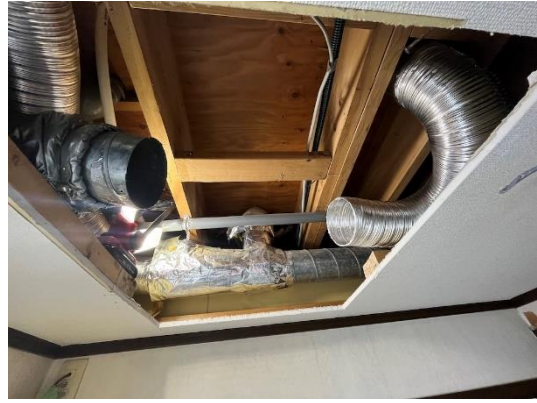
(ii) 天井解体&換気システム本体取外し後
