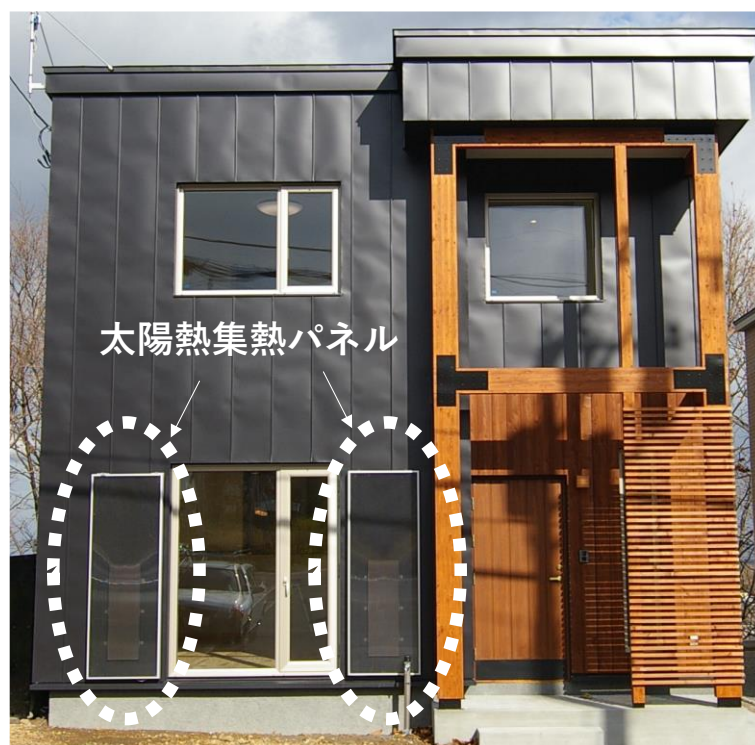
図 3.2 SAH 設置状況
