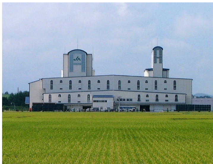
図 1-1 米の共同乾燥調製貯蔵施設（上川ライスターミナル），対象面積 4,000ha，粳荷受量 20,000t，サイロ粳貯蔵能力 10,000t，荷受トラック 6,500 台／年間
