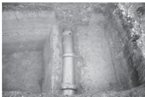
H. TP 16 土管（東より）
