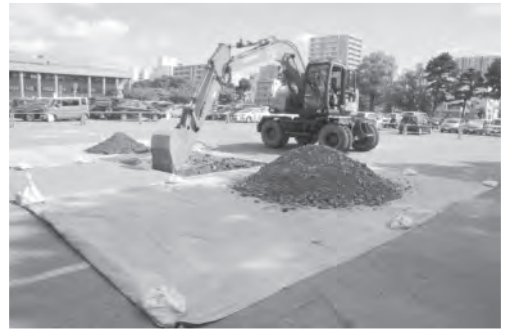
B. 調査の様子（TP 02：南西より）
