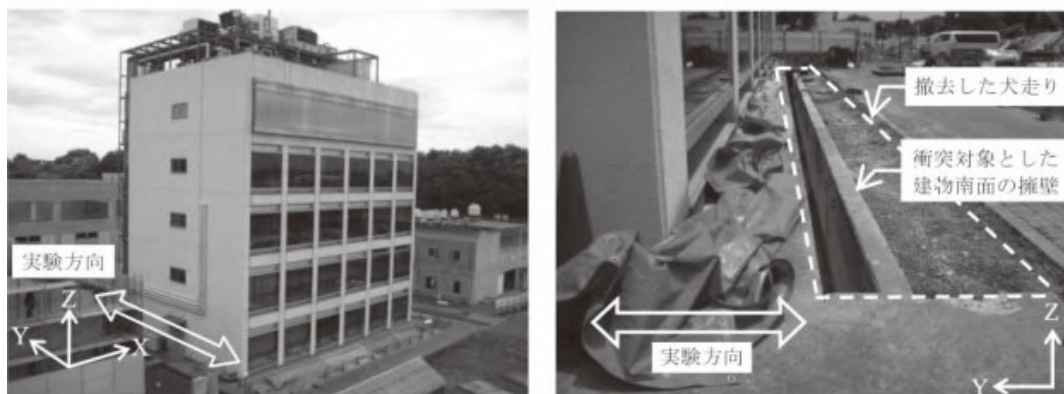
図 1.6 免震建物外観と衝突対象とした南面擁壁
