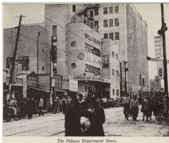
図 4-13 クルーンが訪れたのと同時期だろう、復興が進む福屋デパート周辺。(広島鉄道局旅客課 1949: 8)
