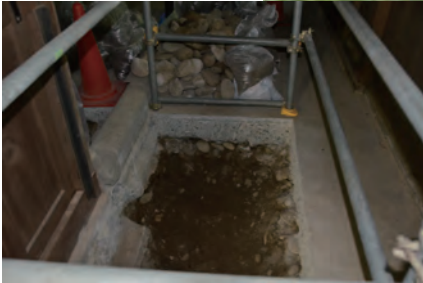
▲秤量所の床下で確認された栗石基礎の一種 床下約20cmの深さで、長軸約15cmの円礫が床下で付設されていた。
