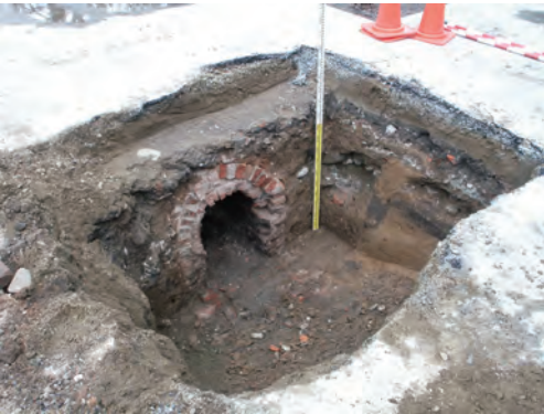
▲経済学研究棟改修工事箇所で確認された暖房施設
