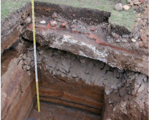
▲農学部農系総合研究棟建設に伴う事前調査で確認したコンクリート梁(上位にレンガが敷設)
