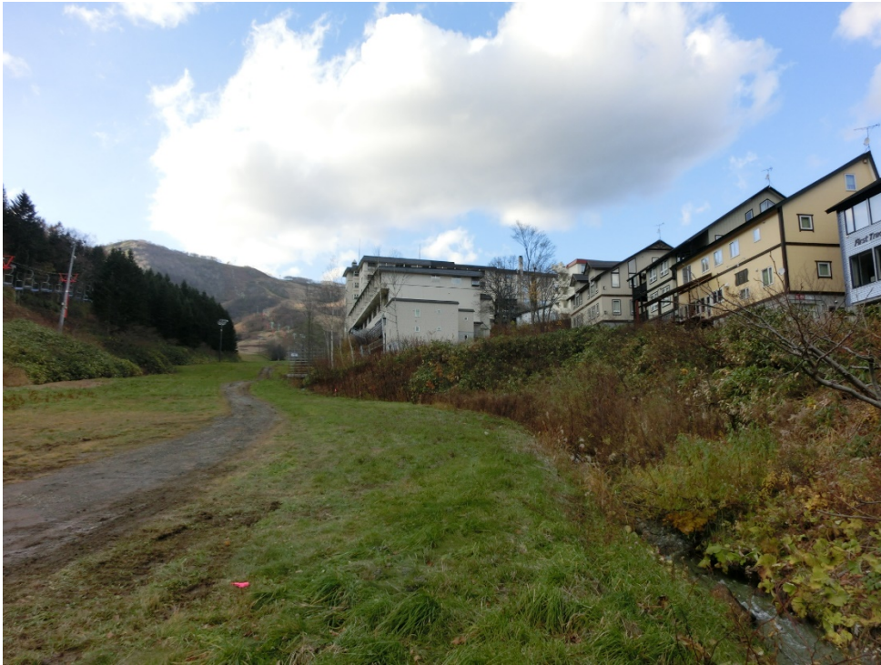
写真VI- 3 - 1 冷水川リフト乗り場付近の様子 （撮影日：2015/10/29）
