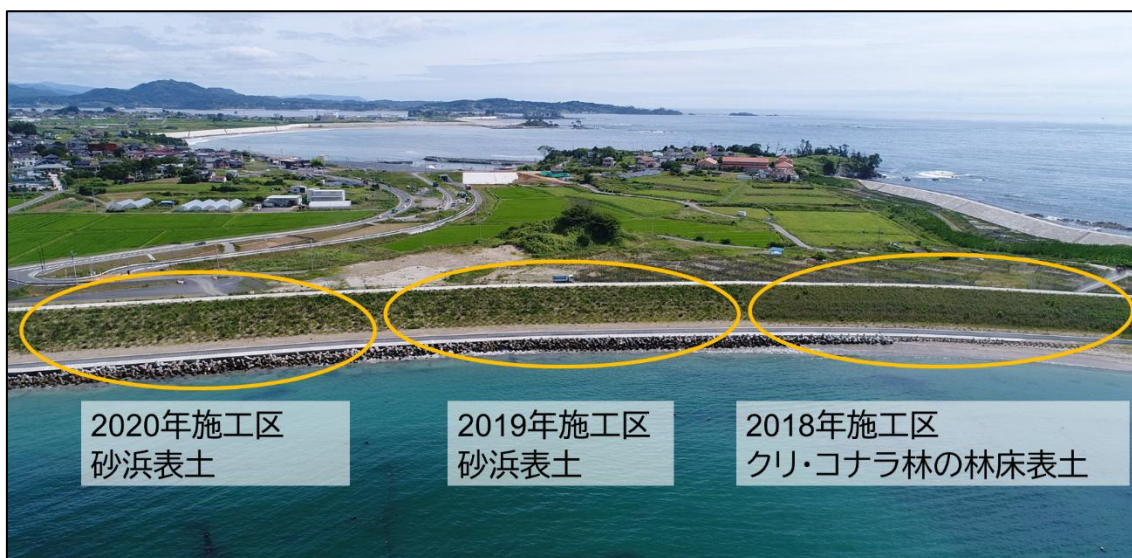
Figure 5-3. 三島海岸の防潮堤覆砂と施工区の様子.
