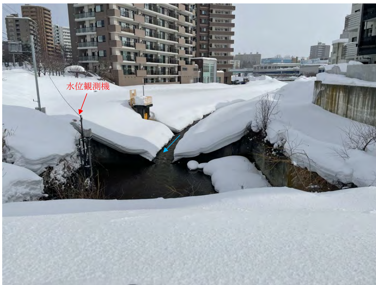
図 2.3.18(1) 三里川下流水位観測所地点（令和4年2月20日撮影）
