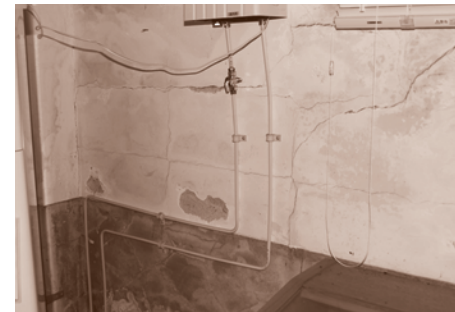
2018年9月6日に起こった北海道胆振東部地震による旧・展示本館への影響。各所で壁が剥落し、膨大な数のクラックが新たに生じました。(2018年9月13日撮影)
