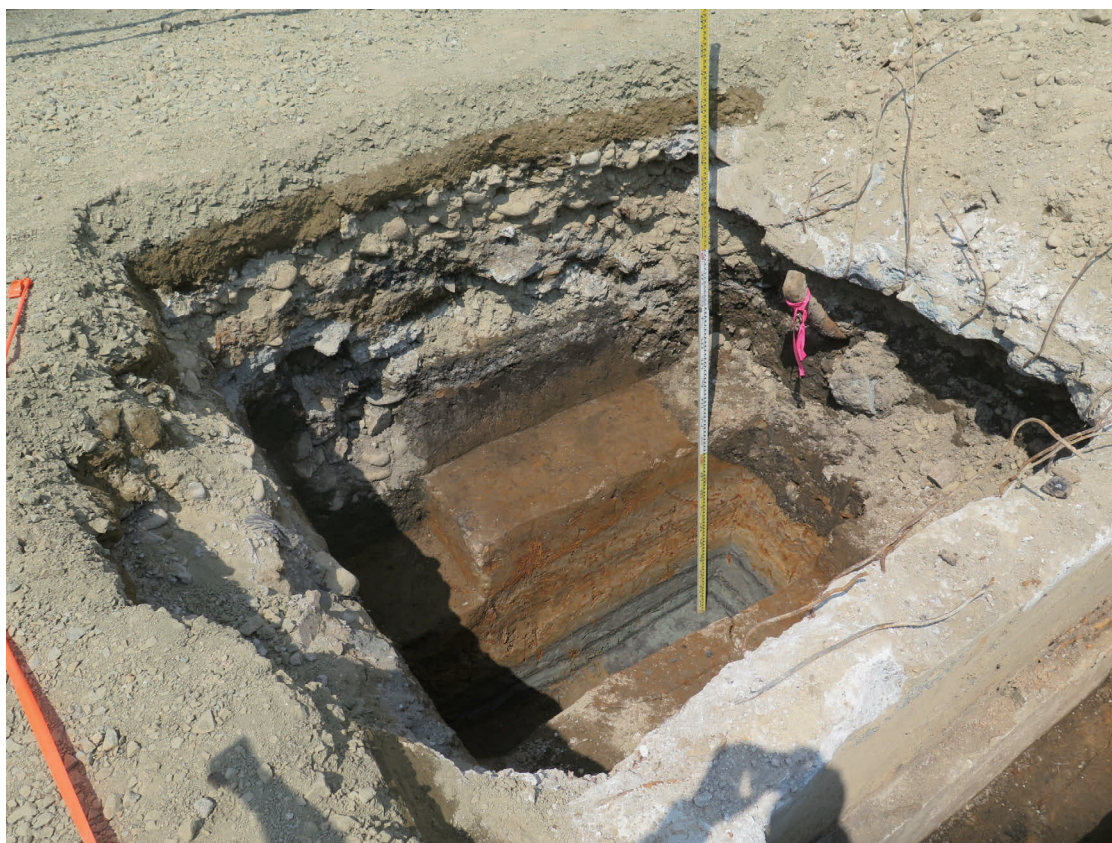
写真 1 TP06 の西壁セクション及び調査状況
