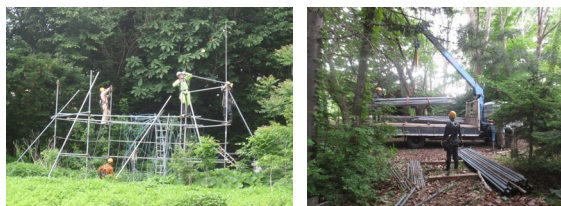
図-10. FACE-3の解体風景（左）と利用可能な単管の移動（右）
