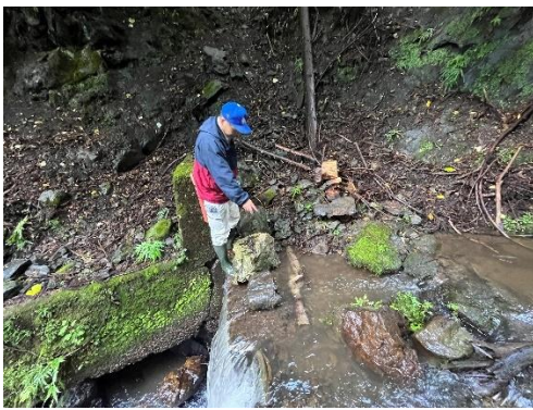
写真 37 水道整備③
