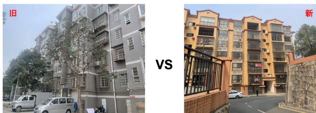
図 10 湘雄新苑の新旧建築対照
