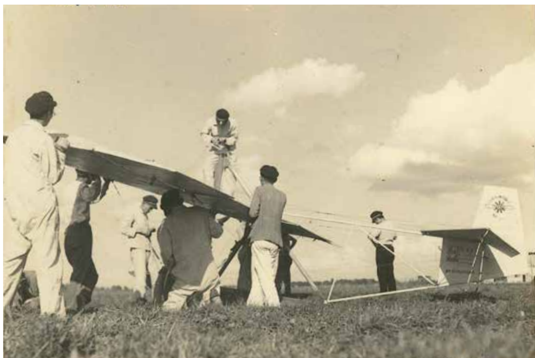
図3 プライマリーへのゴム牽の装着 (1941 年 9 月 5 日)
