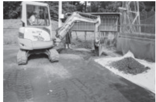
D. 野球場 A バックネット改修整備工事 TP 01 掘削状況（南より）調査番号：2421
