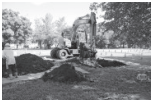
D. 未来創造棟新営工事 TP 04 掘削状況 (南西より) 調査番号：2415
