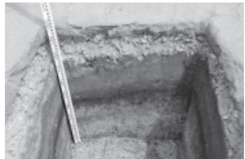
F. 野球場 A バックネット改修整備工事 TP 05 北東壁（南西より）調査番号：2421
