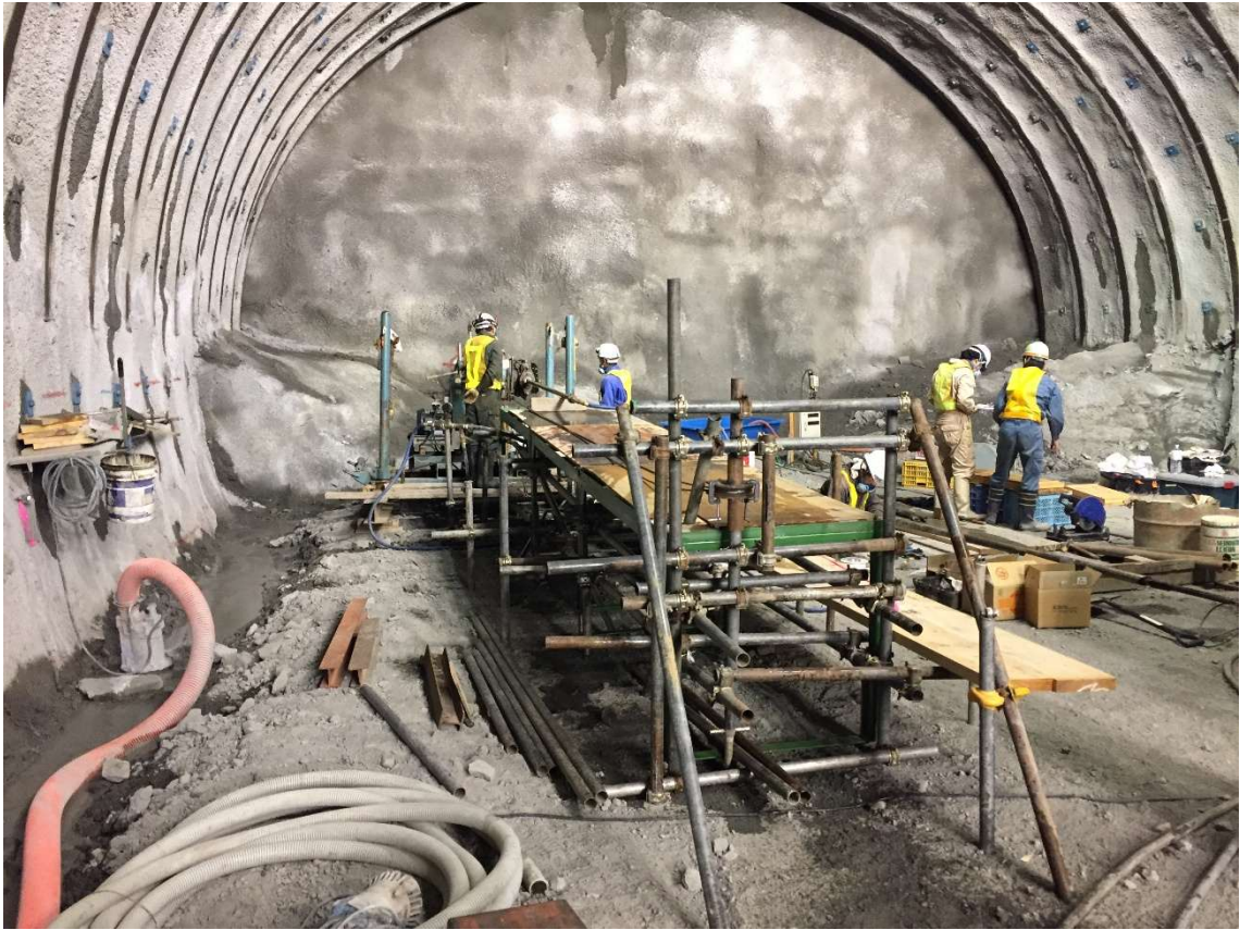
トンネル工事における先進ボーリング調査状況①
