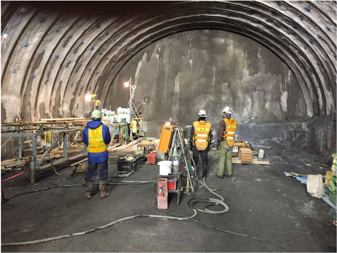
トンネル工事における先進ボーリング調査状況③
