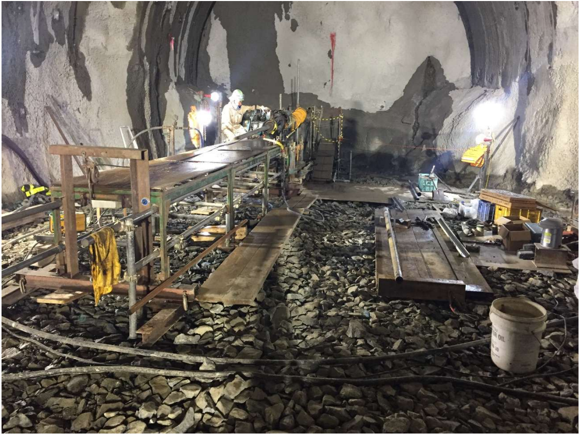
トンネル工事における先進ボーリング調査状況②
