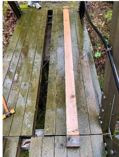
写真 3-17 床版材背面部
