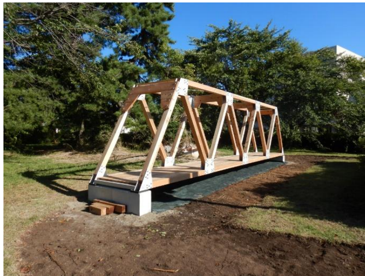
写真 3-43 改良した木製ワーレントラス橋（2023 年モデル）
