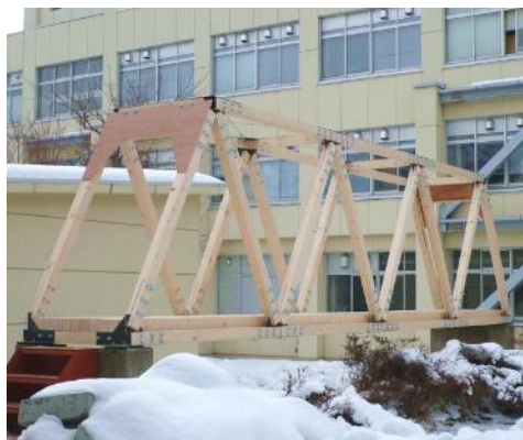
写真 3-34 木製ワーレントラス橋 (2010 年モデル)
