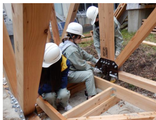
写真 4-38 ボルト連結作業
