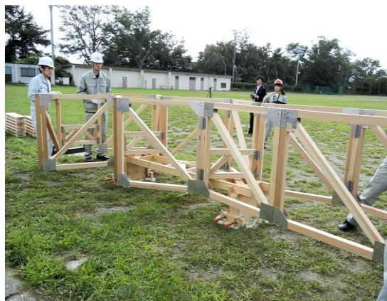
写真 4-16 架設台上で橋を展開
