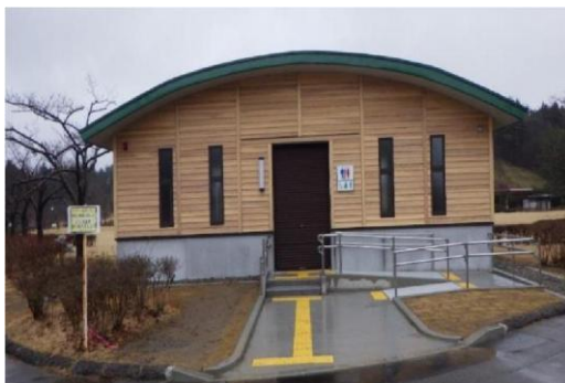
写真 1-4 公衆トイレ（秋田県秋田市） 27)
