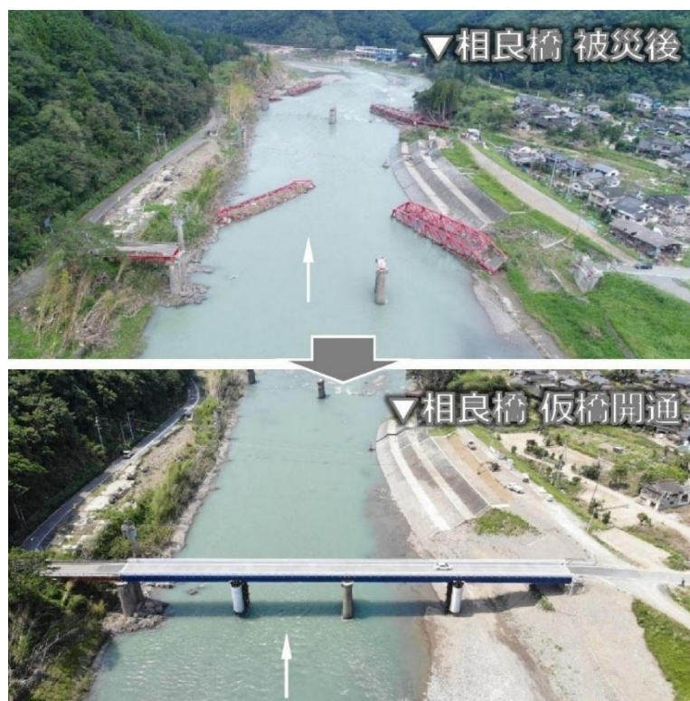
写真 2-7 球磨川相良橋仮橋開通 1),9),10)
