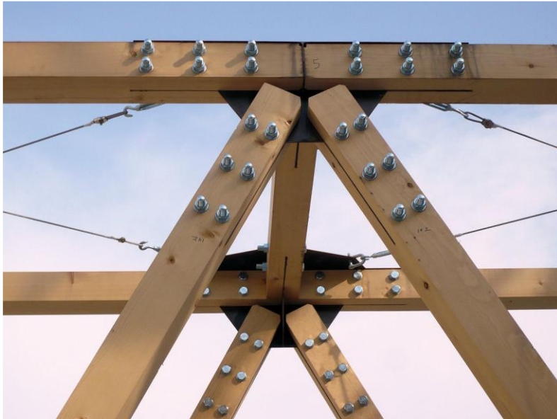
写真 3-3 格点構造
