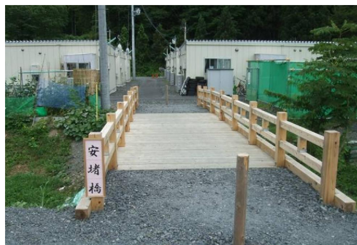
写真 2-10 安堵橋完成状況 14),20)
