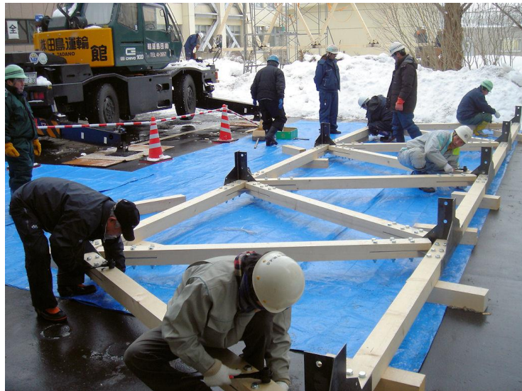
写真 3-5 架設作業の状況
