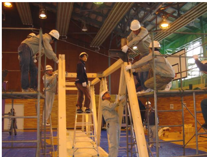
写真 3-4 屋内架設実験の状況
