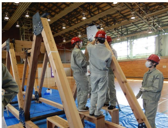
写真 3-47 屋内での組み立て作業
