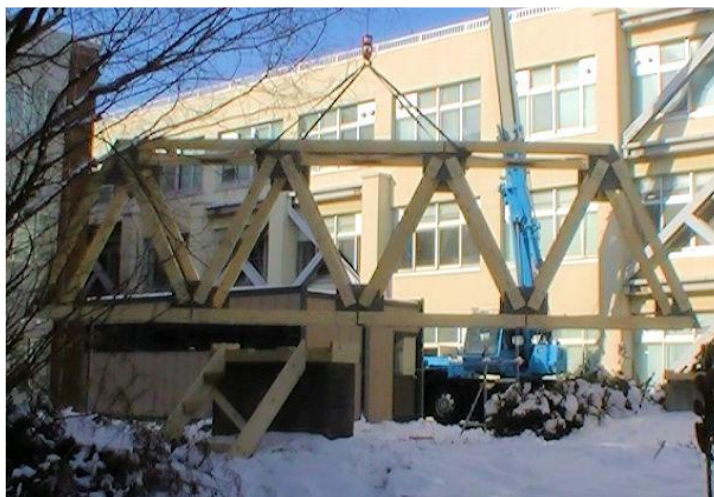
写真 3-30 クレーン一括架設
