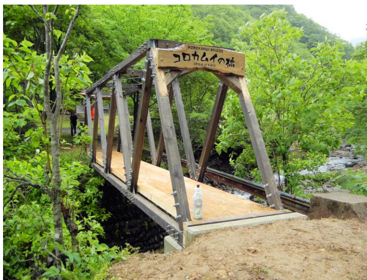
写真 3-11 完成時の状況（平成 27 年（2015 年）6 月）
