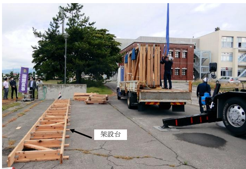
写真 4-22 架設台の設置
