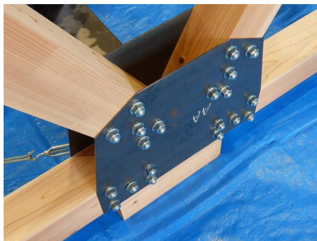
写真 3-44 中間部のトラス接合
