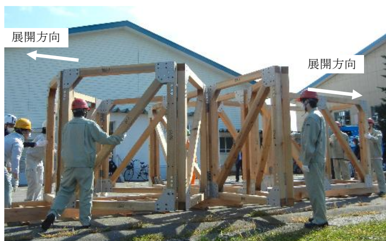
写真 4-24 折り畳み橋の展開作業
