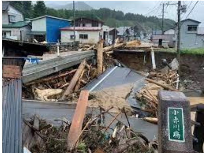
写真 2-2 小赤川橋の落橋 3)
