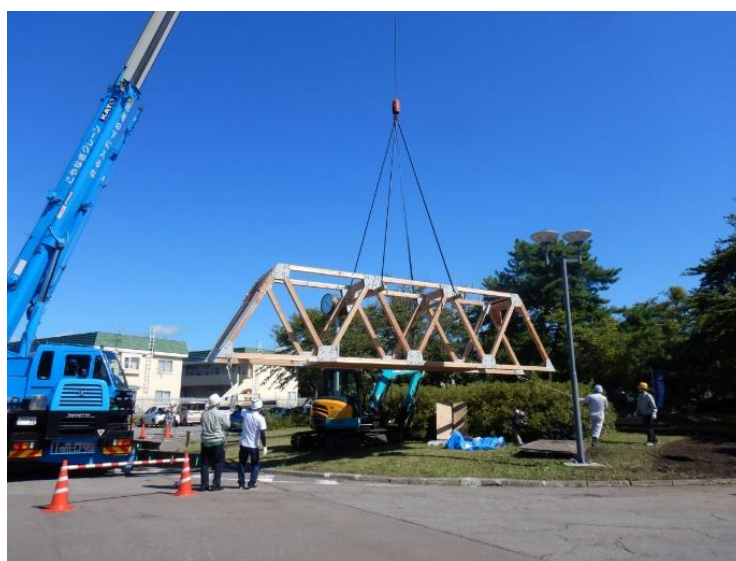
写真 3-51 クレーン一括架設
