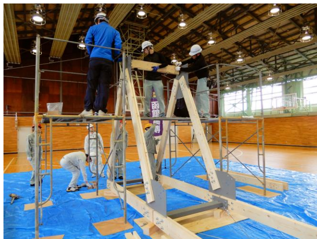
写真 3-25 足場を用いた組立作業
