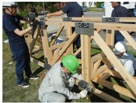
写真 4-17 補強鋼板の取り付け
