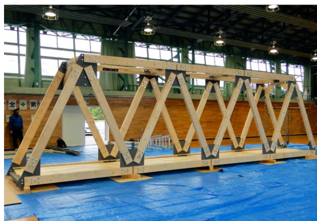
写真 3-26 屋内架設実験完了時
