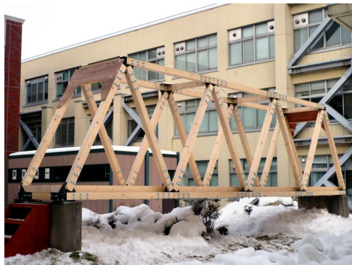
写真 3-6 完成時の状況（2010 年 1 月）
