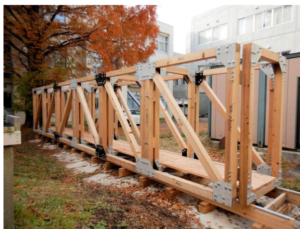
写真 4-39 完成時の状況
