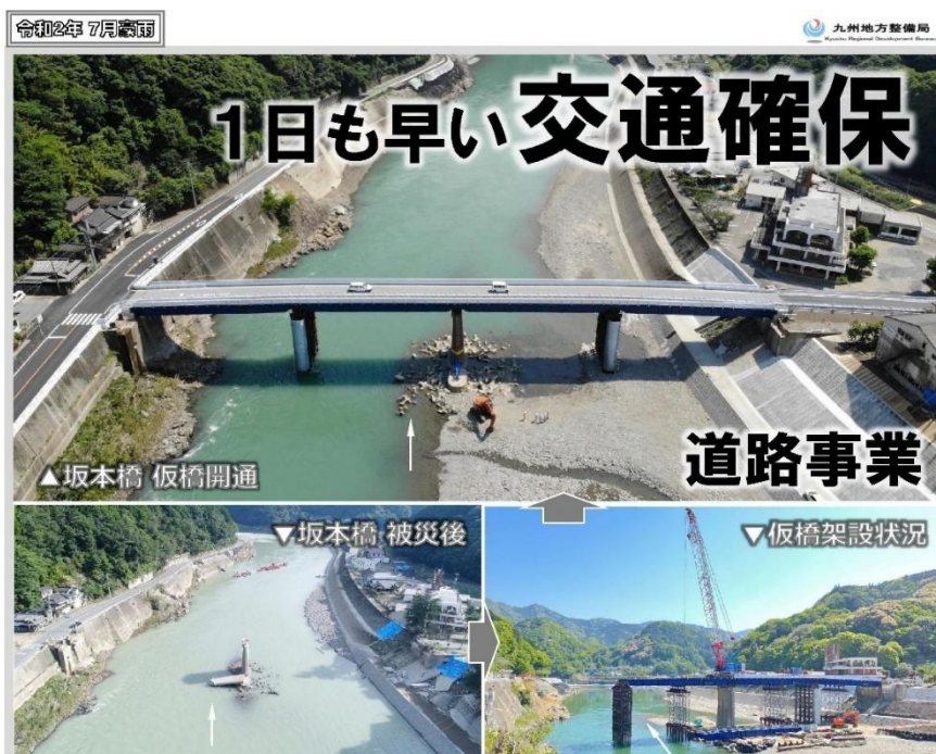
写真 2-6 球磨川坂本橋 仮橋開通 1),9),10)
