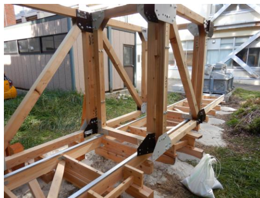
写真 4-35 トラスパネルの連結
