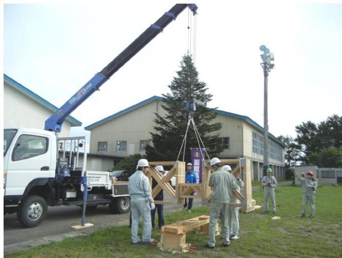
写真 4-15 折り畳み橋を架設台へ設置
