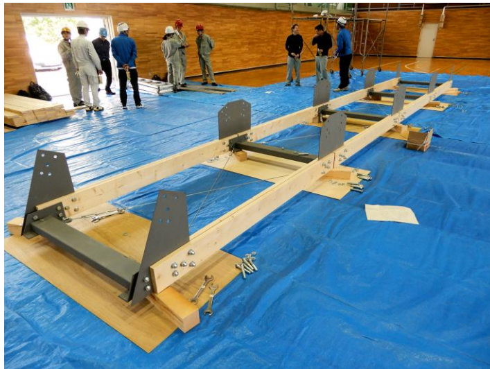
写真 3-24 下弦材連結完了時
