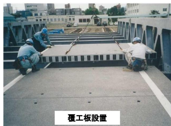
写真 2-5 応急組立橋組立手順 8)
