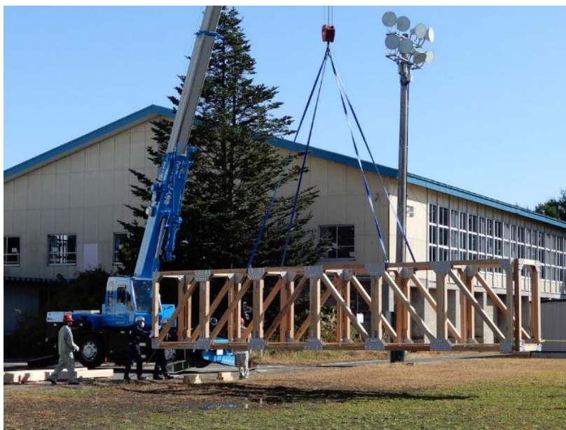
写真 4-26 クレーンによる一括架設
