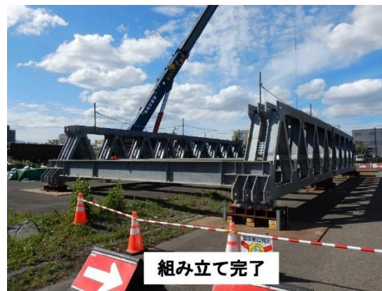
写真 2-5 応急組立橋組立手順 8)
