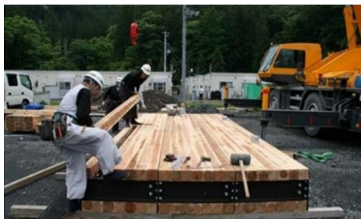
写真 2-9 安堵橋組立状況 14),20)
