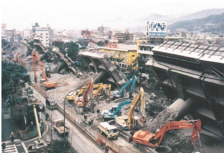
写真 1-1 平成7年（1995年）阪神・淡路大震災 阪神高速神戸線高架橋の倒壊被害 6)
