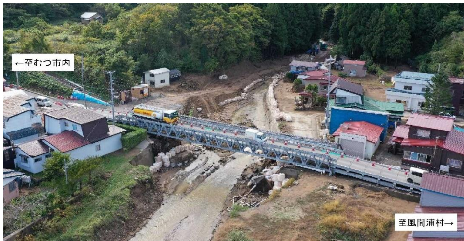
写真 2-8 応急組立橋供用状況（むつ市） 11)
