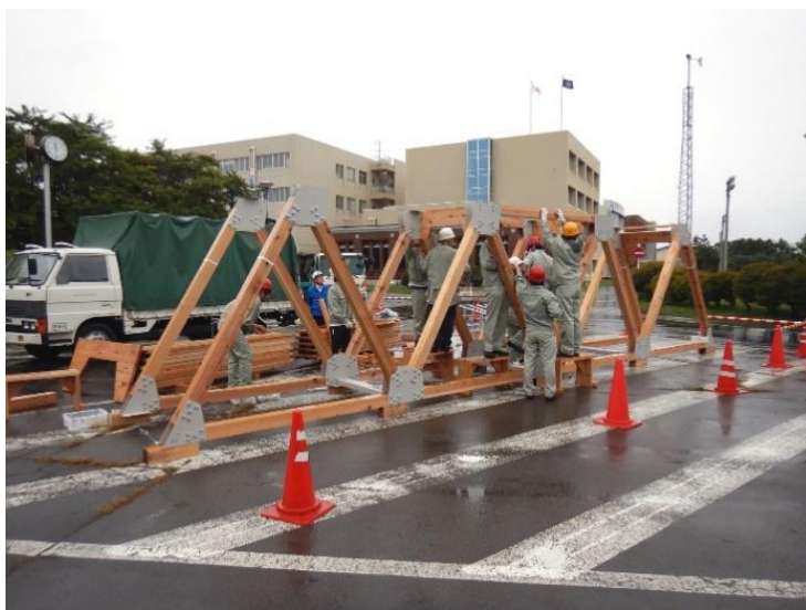
写真 3-50 屋外での組み立て作業
