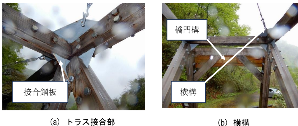
写真 3-14 接合部および横構
