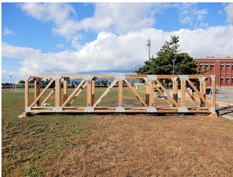
写真 4-27 架設完了時の状況
