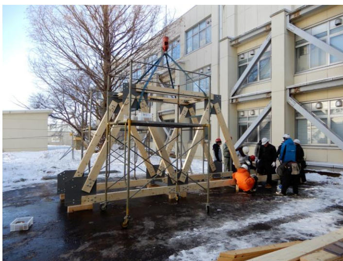
写真 3-28 地上での作業状況
