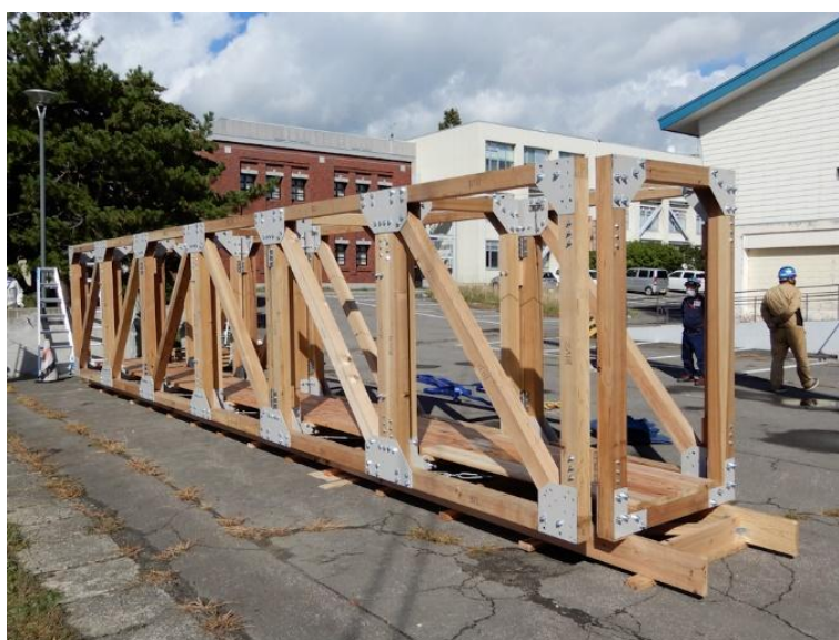
写真 4-25 架設台上での組み立て完了
