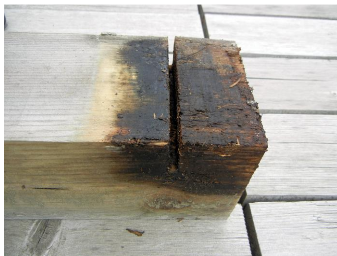
写真 3-9 床版部材の裏面端部
