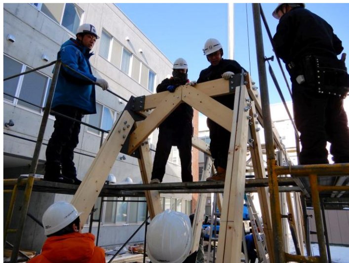
写真 3-29 足場上での作業状況
