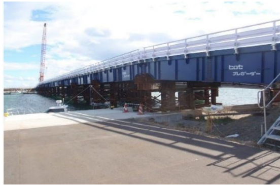
写真 1-6 工事用仮橋（宮城県名取市） 37)
